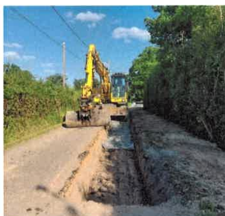
Une portion du chemin du Boudet haut a été rénovée
